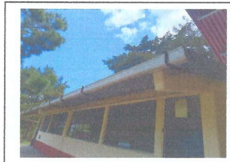
Foto 2: Cambio de canales y caidas pluviales
