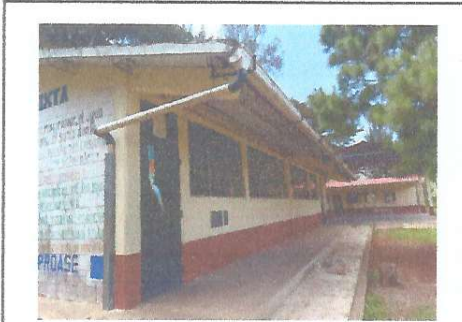
Foto 1: Cambio de canales y caidas pluviales
