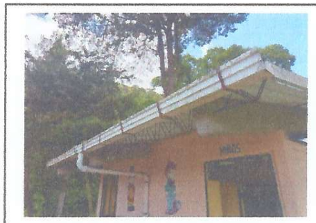
Foto 4: Cambio de canales y caidas pluviales
