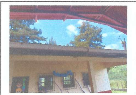
Foto 3: Cambio de canales y caidas pluviales
